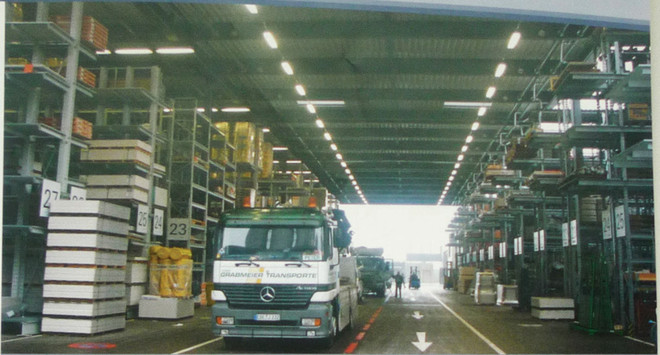
Das neue Baustoff-Logistik-Zentrum
